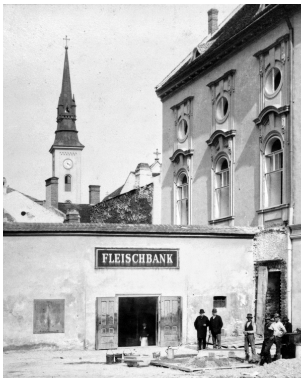
Obr. 1 Brněnské zděné masné krámy na Zelném trhu. AMB, fond U5, i. č. VIIIe16.
