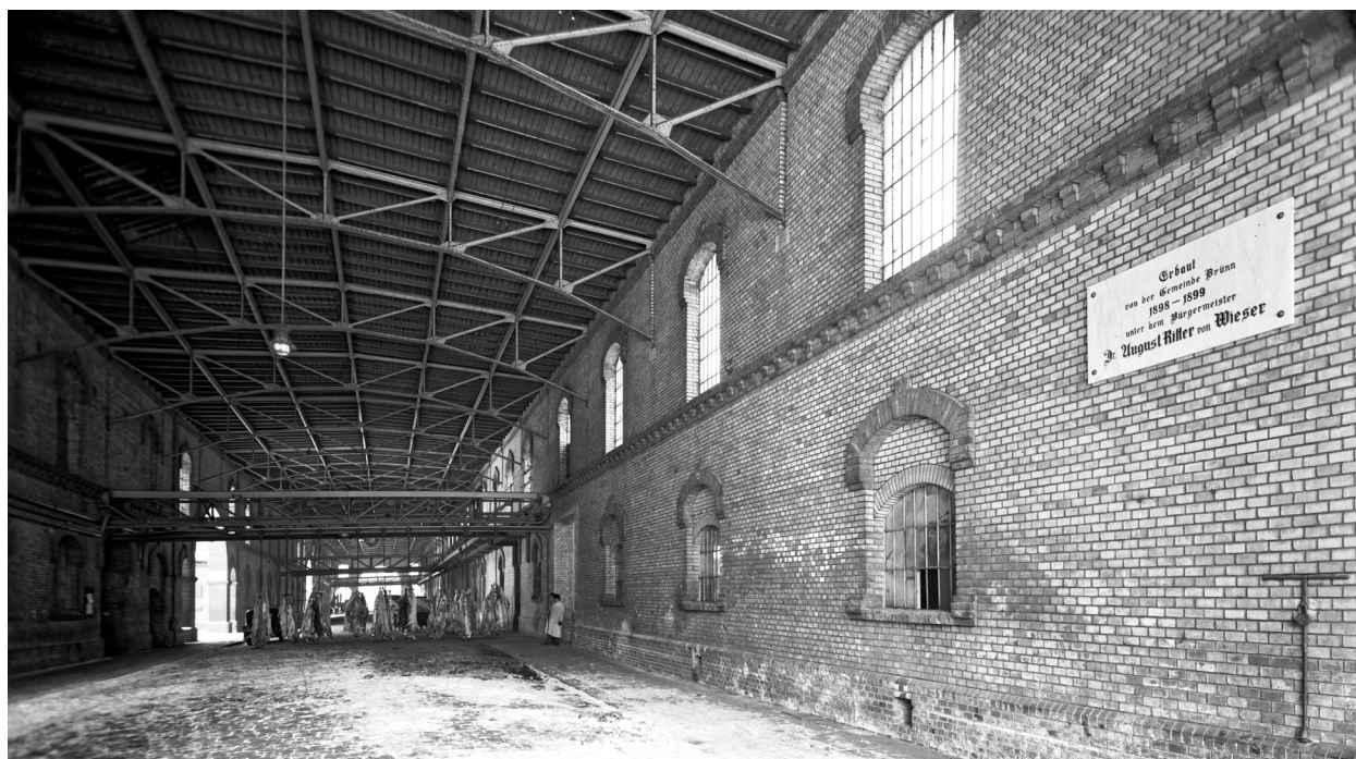
Obr. 8 Brněnská jatka, budova z roku 1899. TMB, i. č. 20.30-02174-1.
