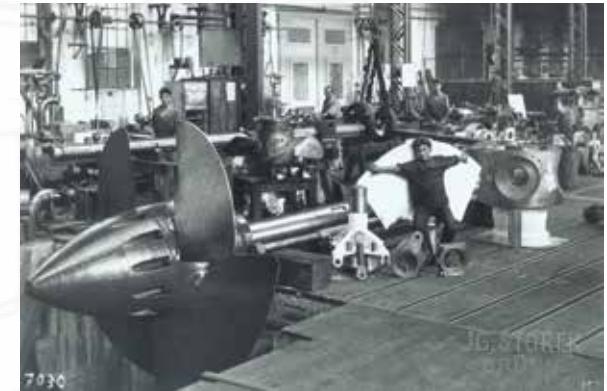
Ein Blick in die Produktion von Kaplan-Turbinen in der Firma Ignaz Storek
